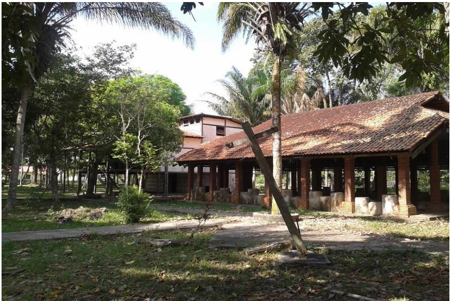
O total abandono das edificações no Poramtim do Bom Socorro
